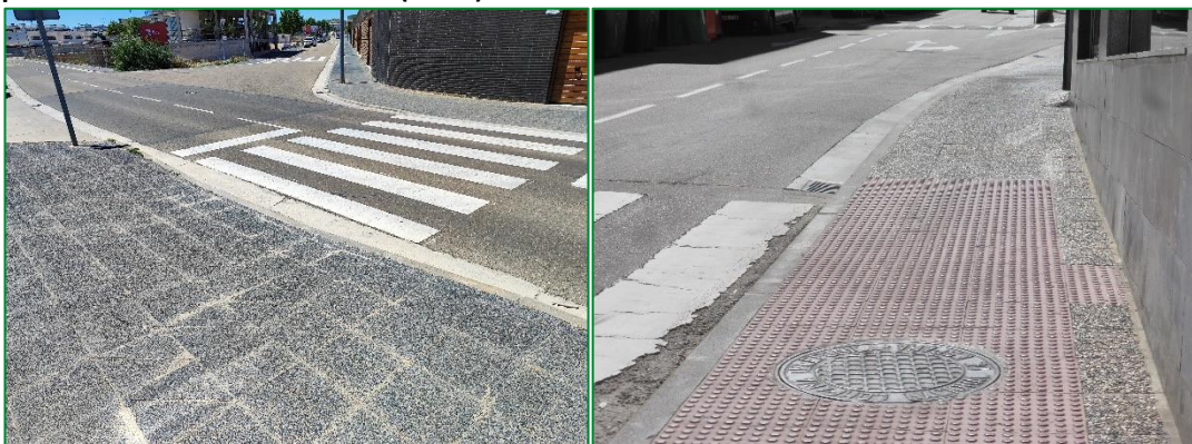
Imagen 6. Pasos para peatones sin pavimento podotáctil ni encaminamientos (izq.) y pasos para peatones totalmente accesibles (dcha.)
